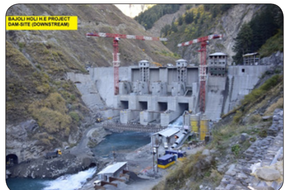
Bajoli Holi Hydro Project
